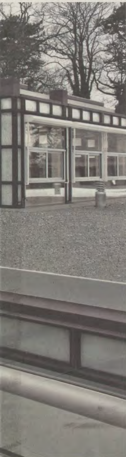
Ci-contre: Un réseau d'acier forme un cadre continu sur le pourtour du bâtiment. Le verre, transparent ou translucide, représente 80% de la façade. (LAURA KELLER SANINA)
