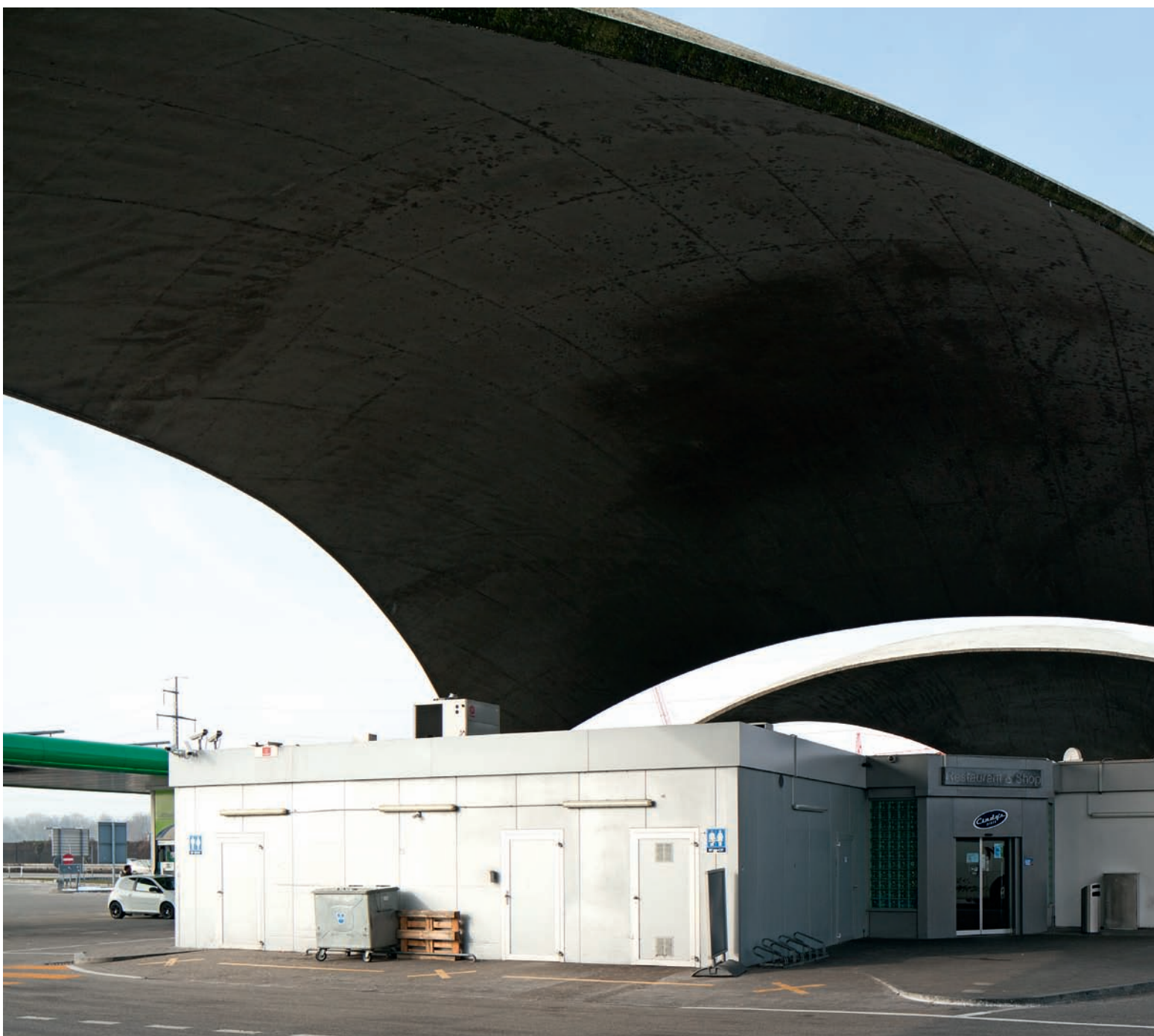
Station service Deitingen sud, Heinz Isler ingénieur, 1968
