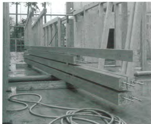
L'école en chantier: portiques en bois et tours de service en béton armé
