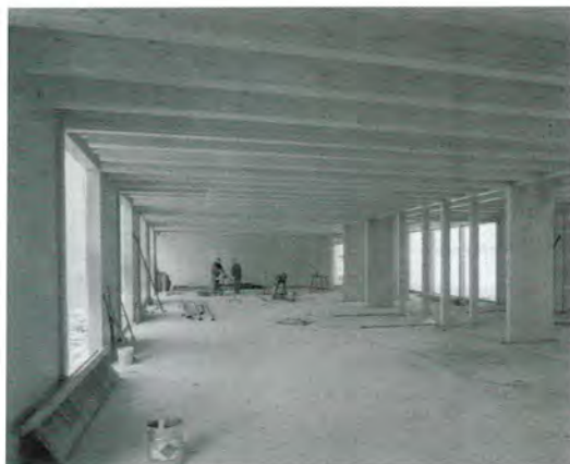
Aile des activités extrascolaires en chantier
