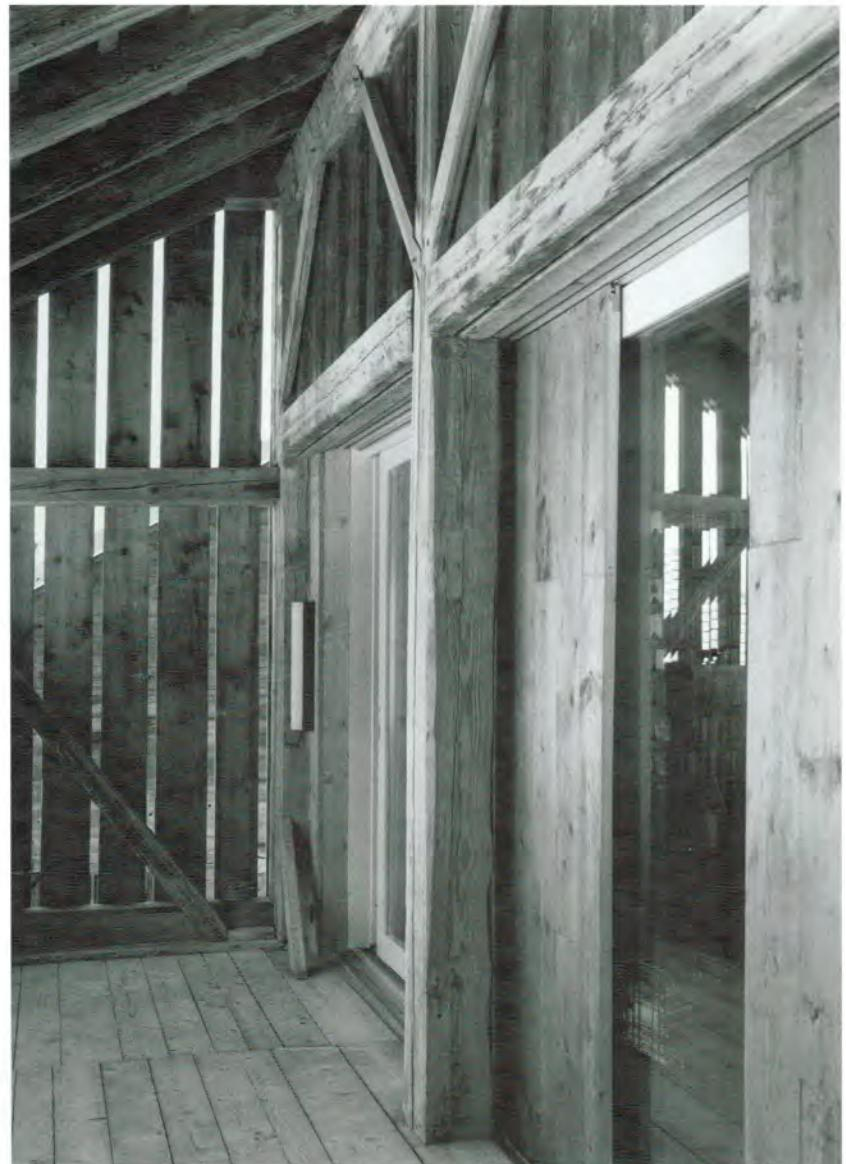
Fig. 22 Façade sur la galerie côté rue. Les parois de planches du fenil ont été adaptées en des volets coulissants devant des baies vitrées.
