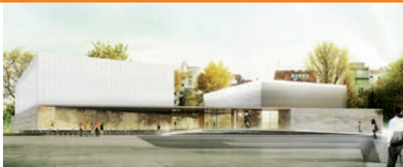
Chantier de la piscine de HautePierre, TNA Architectes
