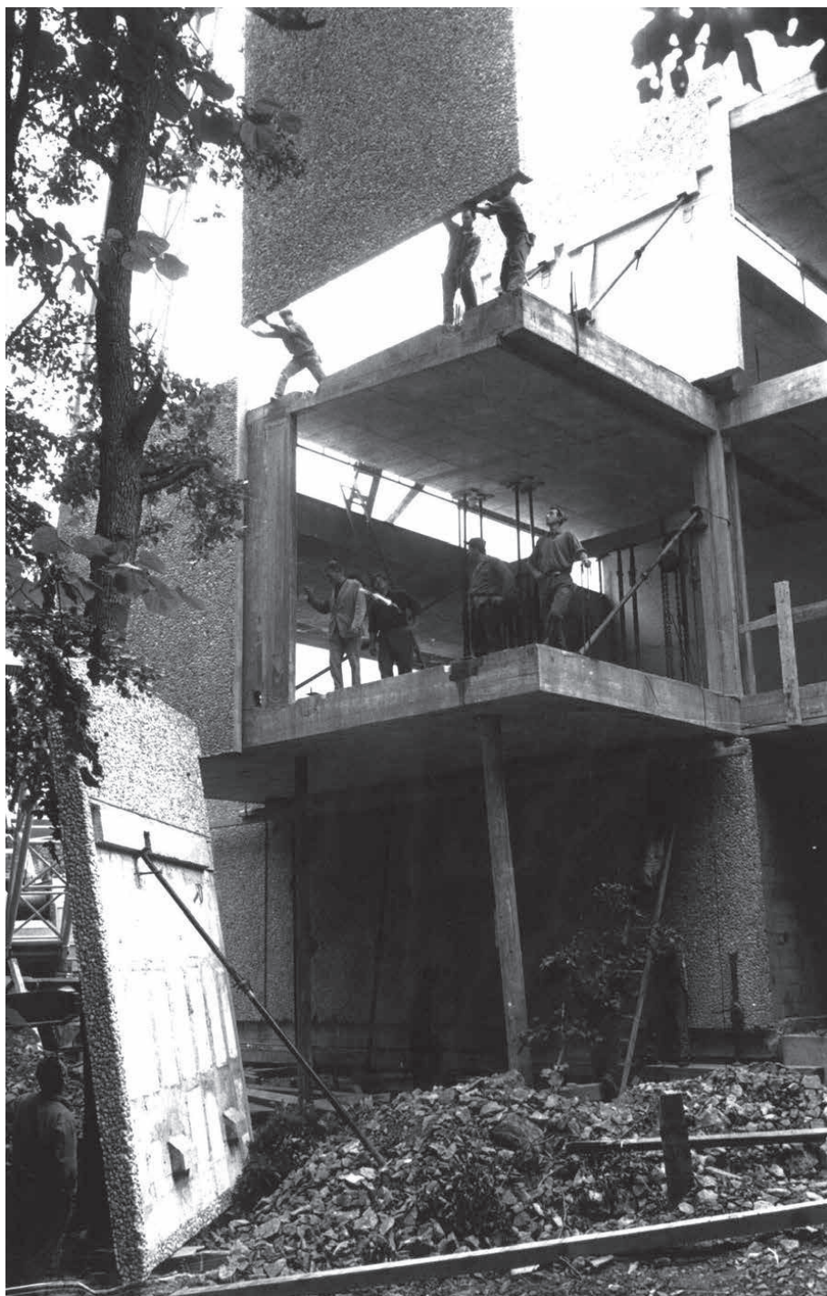
Montage des panneaux de façade en béton préfabriqués. On distingue l'architecte Alfred Habegger en compagnie des ouvriers (Fonds A. Habegger / Photo J.-P. Bailod)
